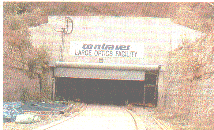
すばるの主鏡の研磨工場はこの中にある。直径約8メートルのガラスを運び込むため、トンネルが掘られ、レールが敷かれた＝米ペンシルベニア州ワンパンで
